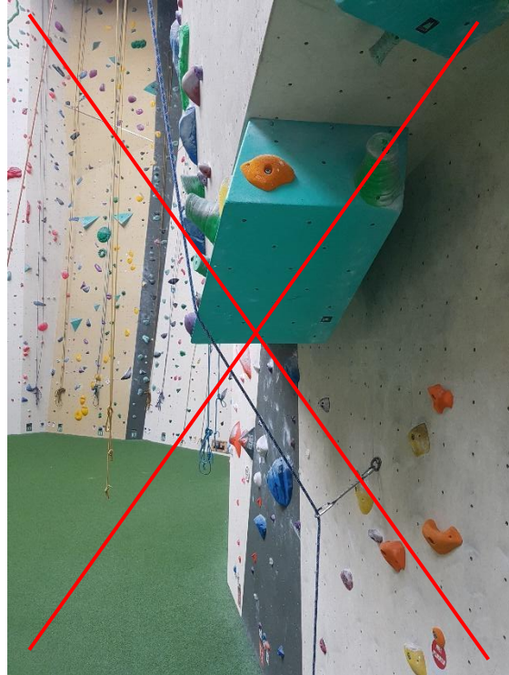
Niet goed. Reële kans op schade aan het touw.
