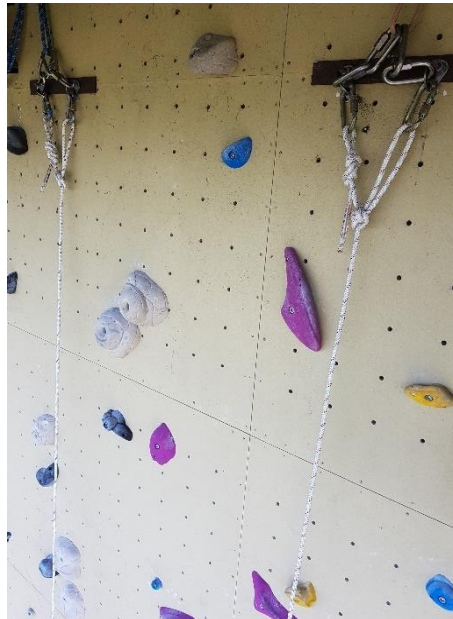
Twee statische touwen bevestigd aan twee haken van twee top-ankers. Beide haken worden belast.
