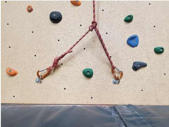
Vast geïnstalleerde routebouwhaken. Krachten verdeeld over twee haken: achtknoop en vlinderknoop.
