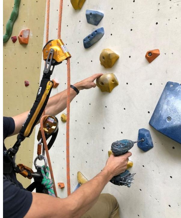
Gordel: industrieel. Touw: dynamisch. Afdaler: Petzl Rig. Back-up: Petzl ASAP met shock absorber. Methode: gepositioneerd om te werken, back-up hoog.
