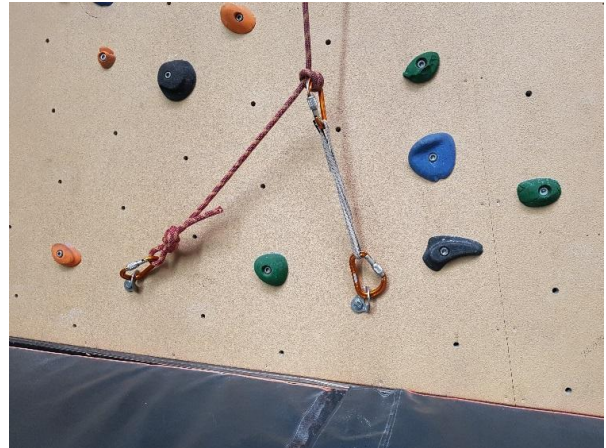
Vast geïnstalleerde routebouwhaken. Krachten verdeeld over twee haken: achtknoop en bandlus met mastworp.
